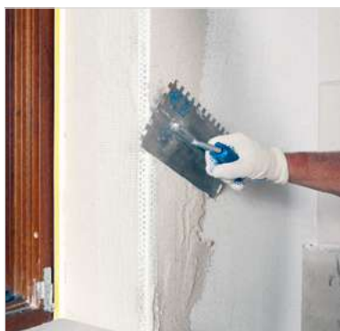
Inštalácia rohového profilu
