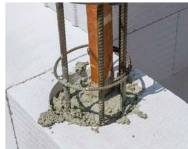
Betónujeme a hutníme postupne s murovaním, najlepšie vždy po položení troch vrstiev muriva.
