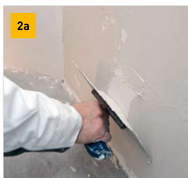
Nanášanie stierky oceľovým hladítkom
