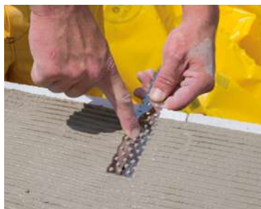
Priebežné vkladanie murivovej spojky do ložnej škáry
