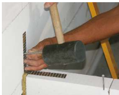
Dodatočná montáž murivovej spojky
