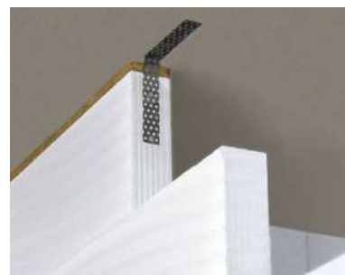
Ukotvenie k stropnej konštrukcii
