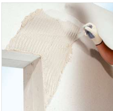
Aplikácia diagonálnej výstuže
