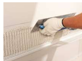
Na založenie nad soklom vždy volíme základacie lišty na externé zateplenie
