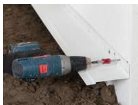
Na založenie nad soklom vždy volíme základacie lišty na externé zateplenie
